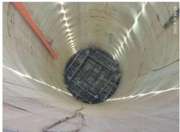
Einbau der Schutzraum Ausbaumodule
