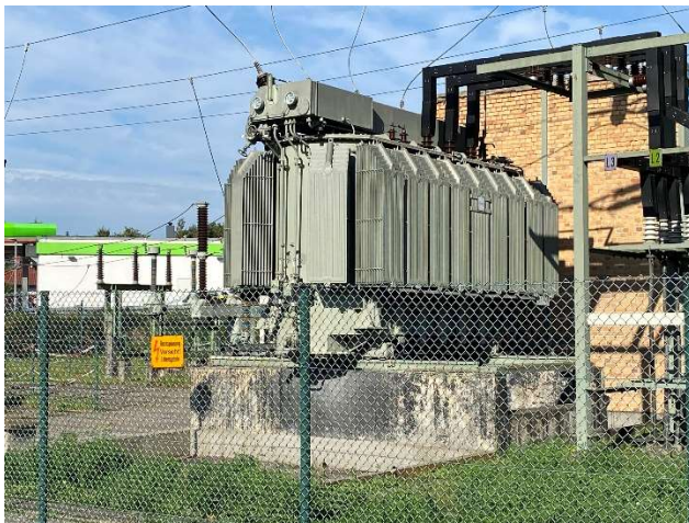
Oberirdische, praktisch ungesicherte Transformatorstation in Deutschland
