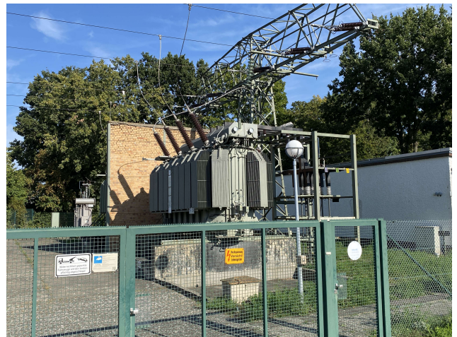
Oberirdische, praktisch ungesicherte Transformatorstation in Deutschland
